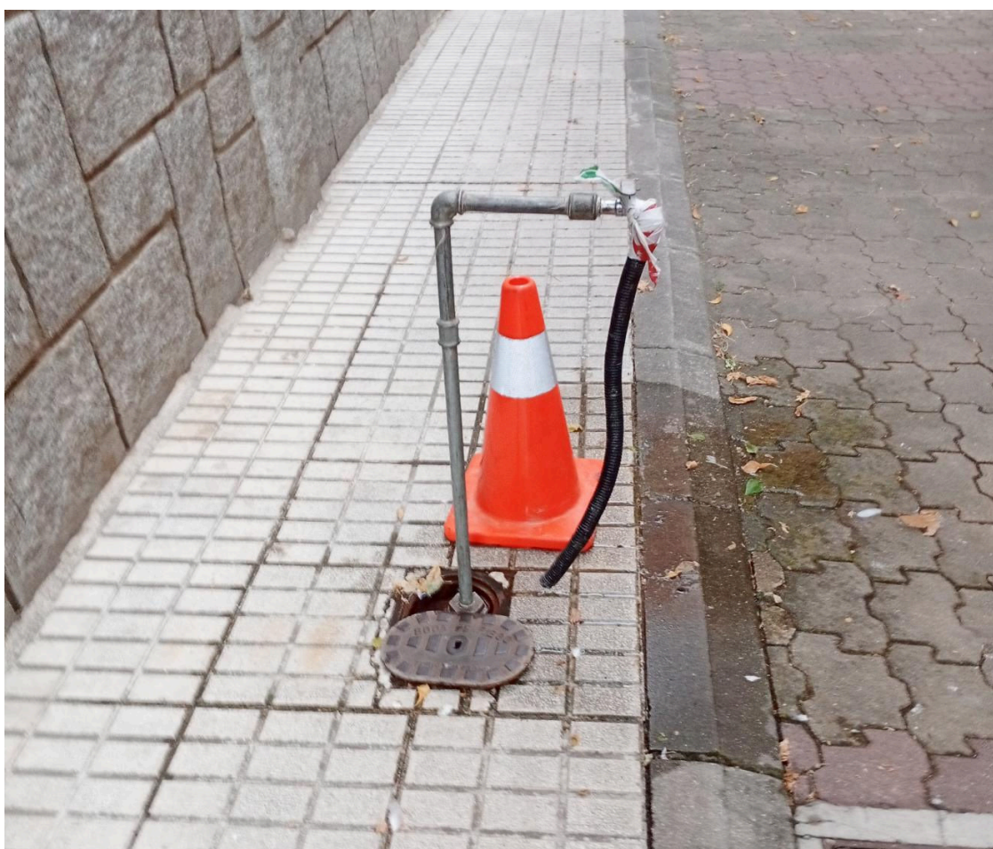
El grifo instalado en la calle Río Francia.
